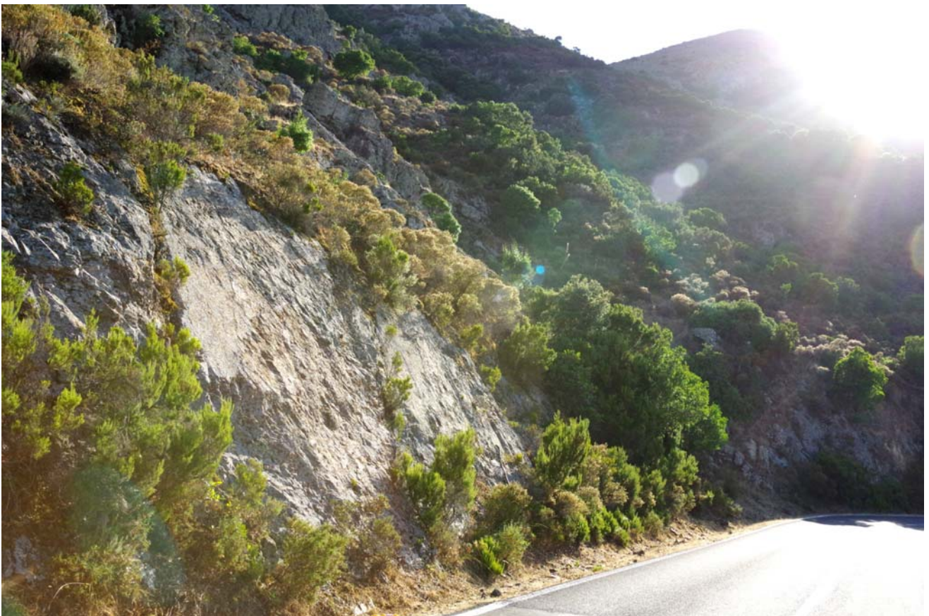
SP 68 Arbus – Montevecchio - Tratto di scarpa a franappoggio al naturale su metamorfiti
