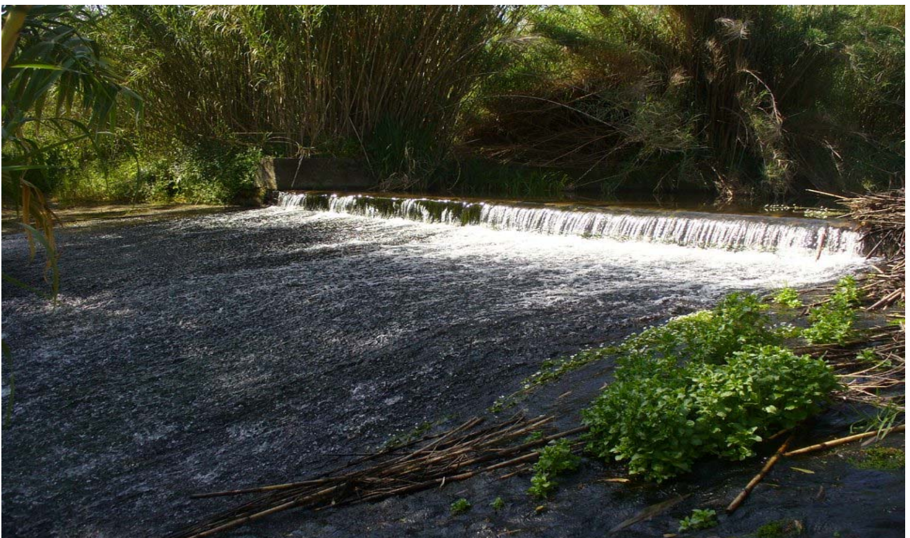
Foto – La soglia sul Terramaistus in località Terra Furca ( alle spalle di San Giorgio)
