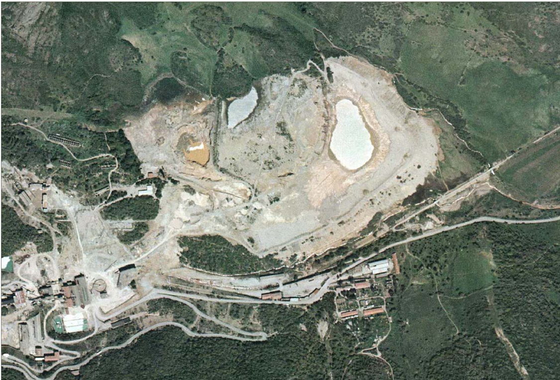
Immagine 2000 con terza diga allo stato attuale e zone di prelievo con costituzione di specchi d'acqua in scavo (miniera non attiva)
