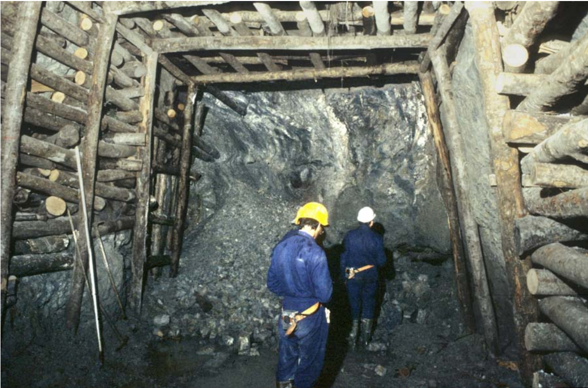
Foto (personale) – 1981 Galleria di coltivazione in direzione a Montevecchio, armata a causa della forte fratturazione della roccia (visibile a sinistra nella fronte galleria)
