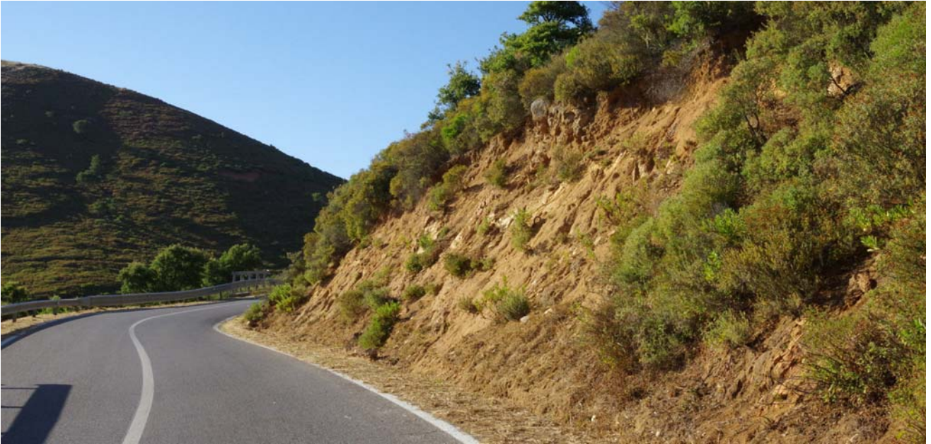
SP 68 Arbus – Montevecchio - Taglio stradale al limite della stabilità nei pressi di Genna Sciria (Comune di Arbus) su granodioriti alterate
