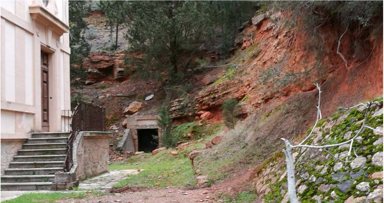
Foto – Rifugio antiaereo a Montevecchio, dietro la palazzina Case Dirigenti scavato nelle formazioni carbonatiche e detritiche eoceniche
