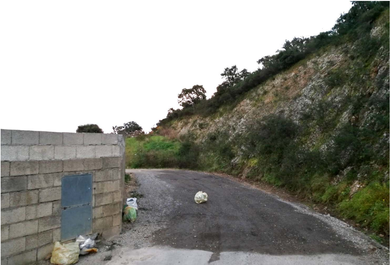
Foto – Il punto di raccordo nel quale una tombatura di un corso d'acqua si inserisce nella statale all'uscita di San Gavino, è segnalato nel PAI come Hg4 su un versante in Hg1
