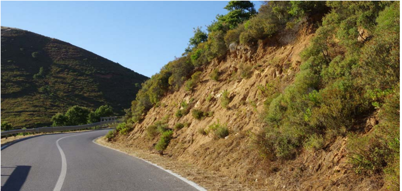
SP 68 Arbus – Montevecchio - Taglio stradale al limite della stabilità nei pressi di Genna Sciria (Comune di Arbus) su granodioriti alterate
