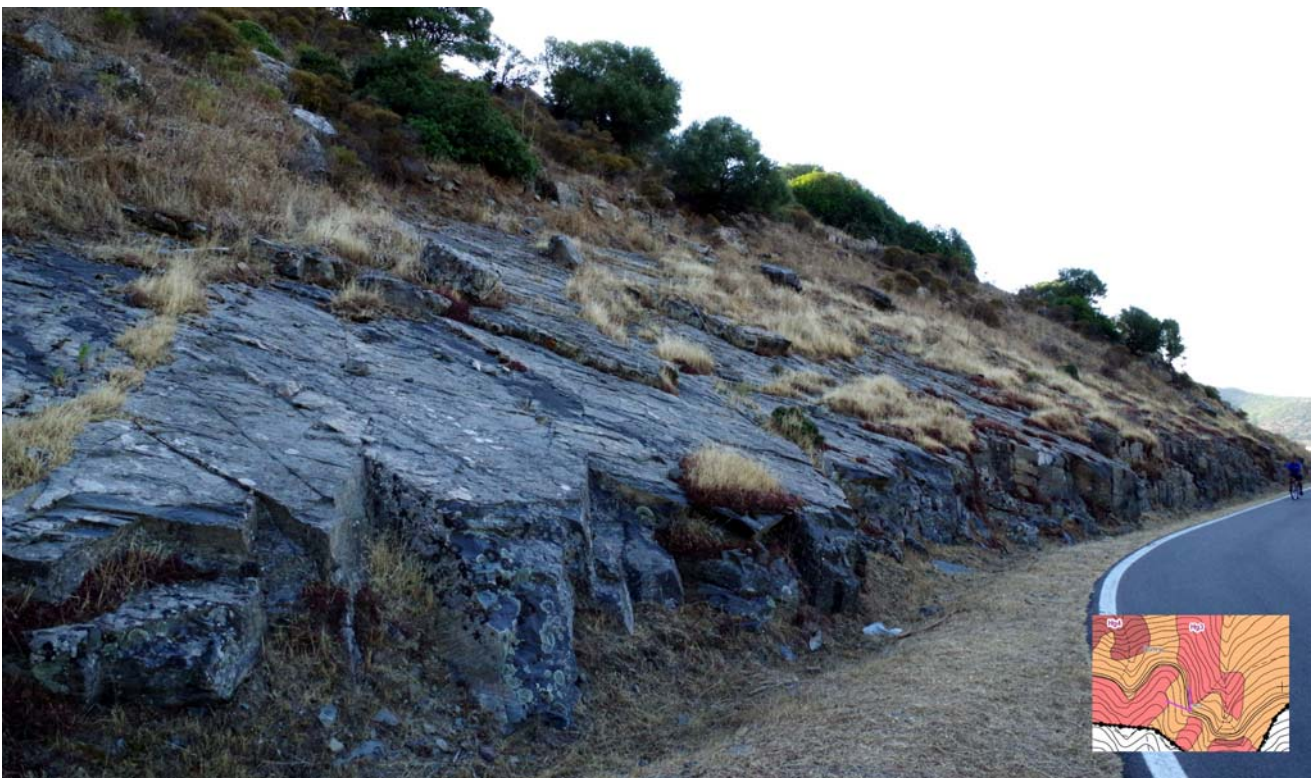
SP 68 Arbus – Montevecchio - Tratto di versante con superficie di strato a franappoggio ed elementi mobili su metamorfiti
