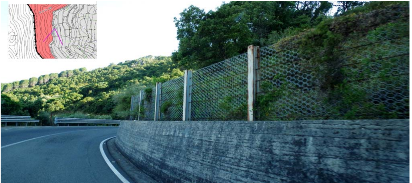
SS 126 km 87+300 - Un taglio stradale con opere di protezione su granodioriti
