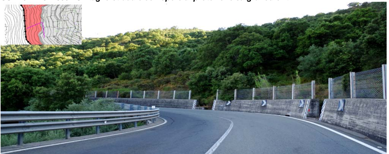
SS 126 km 87+200 - Un taglio stradale con opere di protezione su granodioriti
