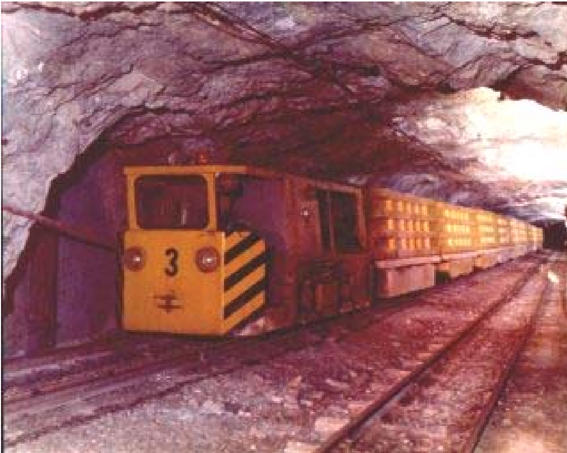
Esempio di galleria di carreggio di grande sezione - Galleria Ornella a Masua-Nebida-Acqua Resi con treno Parkano per il trasporto del minerale, a doppio binario importata nei calcari cambrici, non armata
