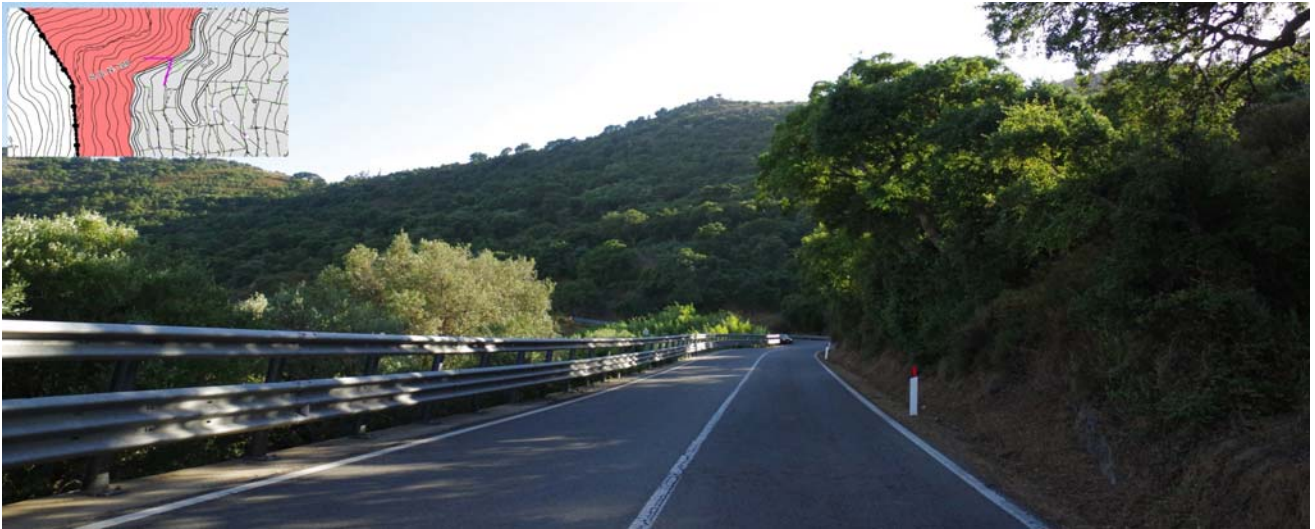
SS 126 km 87+600 - Un taglio stradale con scarpa naturale su granodioriti
