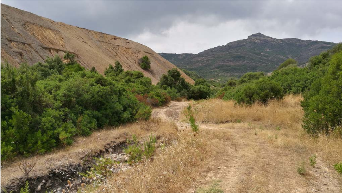
Area del paramento interessato dalla erosione areale e concentrata
