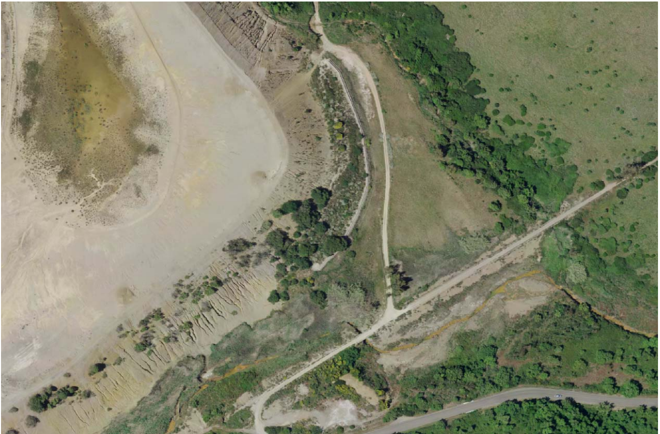
Argini in gabbionata per il confinamento del piede della 3° diga, con presenza di erosione areale e concentrata del paramento della diga e permeazione di acque dal piede del paramento che alimenta la crescita del canneto e viene intercettata e convogliata ad un piccolo impianto di depurazione per l'abbattimento del contenuto in metalli pesanti
