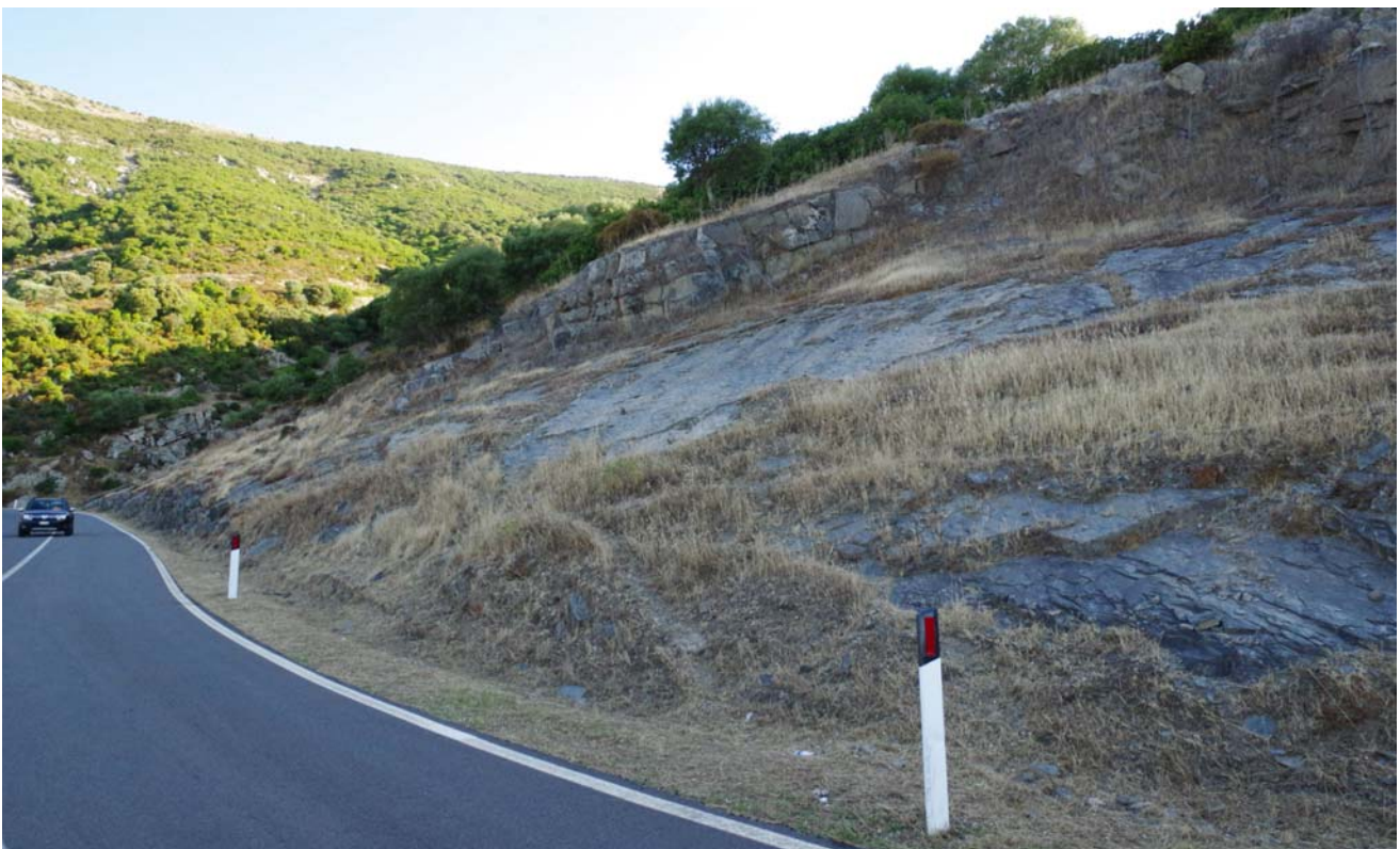
Foto – Versante con stratificazione della SVI a franappoggio lungo la SP Montevecchio – Arbus
