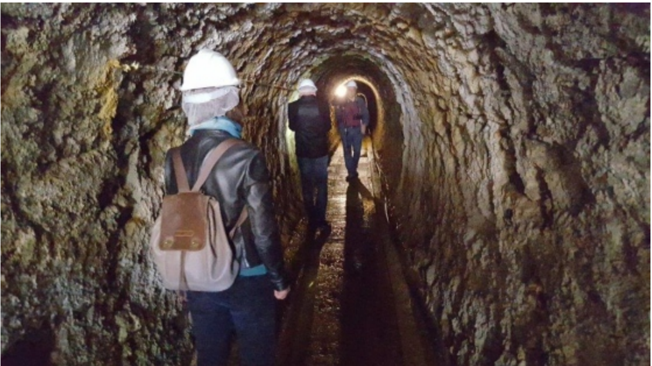
Foto - Galleria Anglo-Sarda nell’area di Pozzo Sartori (‘800 primi ‘900), con sezione ellittica
