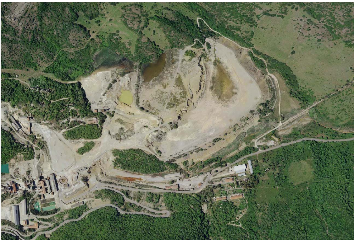
Immagine 2016 con terza diga allo stato attuale e zone di erosione degli argini intermedi tra 1a e 2a e 2 e 3a diga (miniera non attiva)
